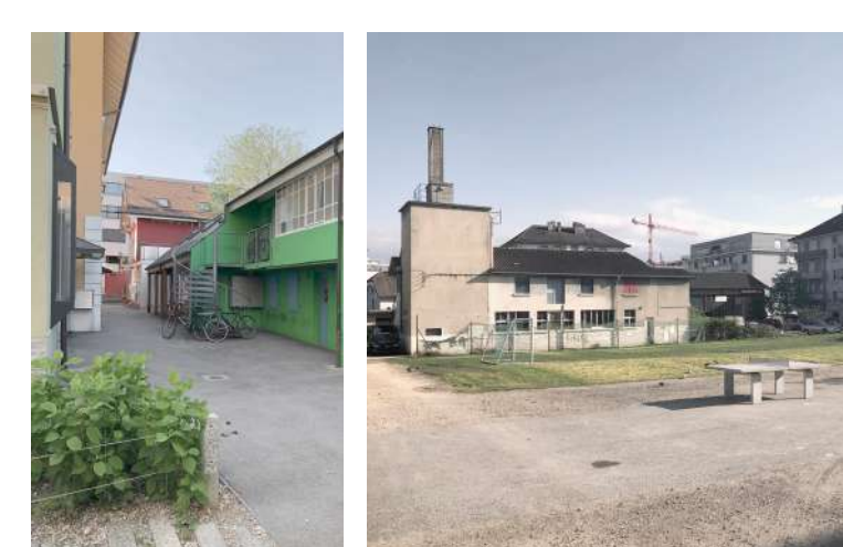
Contexte existant - caractère industriel
