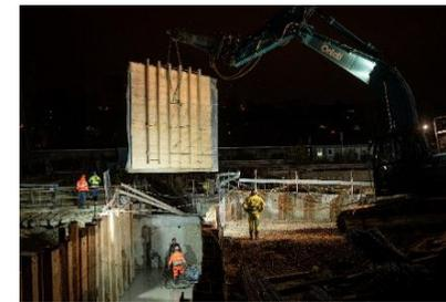
En décembre, l'entreprise de travaux spéciaux a également œuvré à la réalisation d'une ouverture dans le canal exutoire provisoire et réalisé une fermeture dans le canal exutoire définitif de sorte à permettre l'assainissement de ce dernier. Ces ouverture et fermeture ont nécessité une opération nocturne, avec arrêt complet de la STEP, évitant ainsi tout débordement d'eau non traitée dans le milieu naturel, sans incidences toutefois sur la qualité de traitement des eaux usées.
