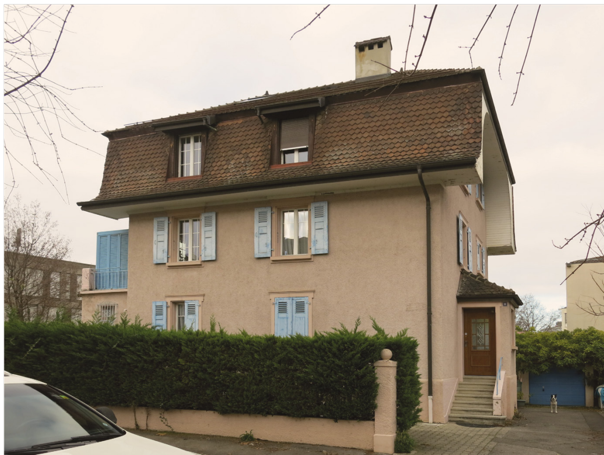
Illustration 4 : Vue façades Sud et Est, Léman 8
