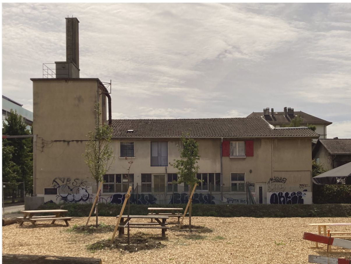
Illustration 1 : Vue de la façade nord, Avenir 9
