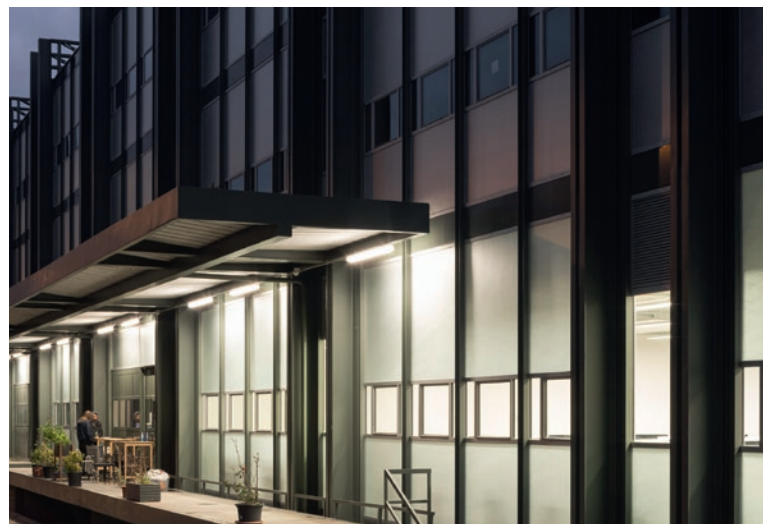
Bâtiment Mayer & Soutter à la rue de Lausanne, rénové par le bureau d'architecture Projet-Co, 2 e prix de la Distinction vaudoise de Patrimoine suisse 2024
